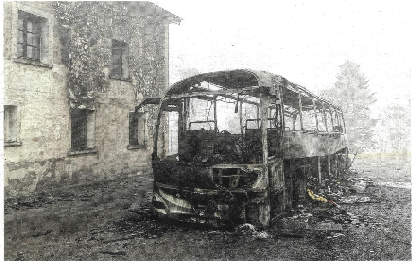
Le feu du car s'est propagé à une aile du centre d'accueil de la Jumenterie. Photos Pascal Chevillot
